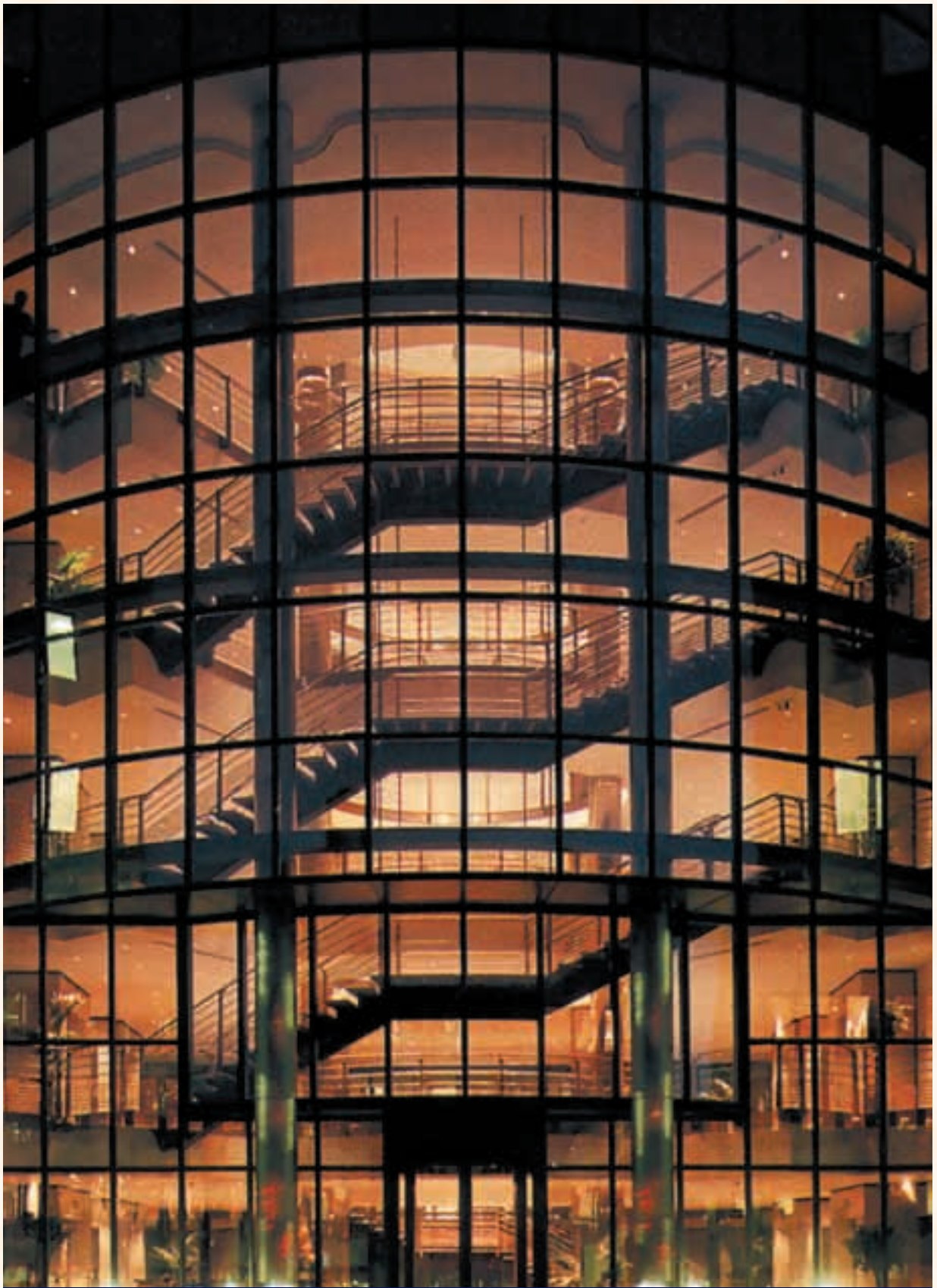
Κτίριο ΠΚ, επιφανείας 17.000 τ.μ., Λουξεμβούργο
