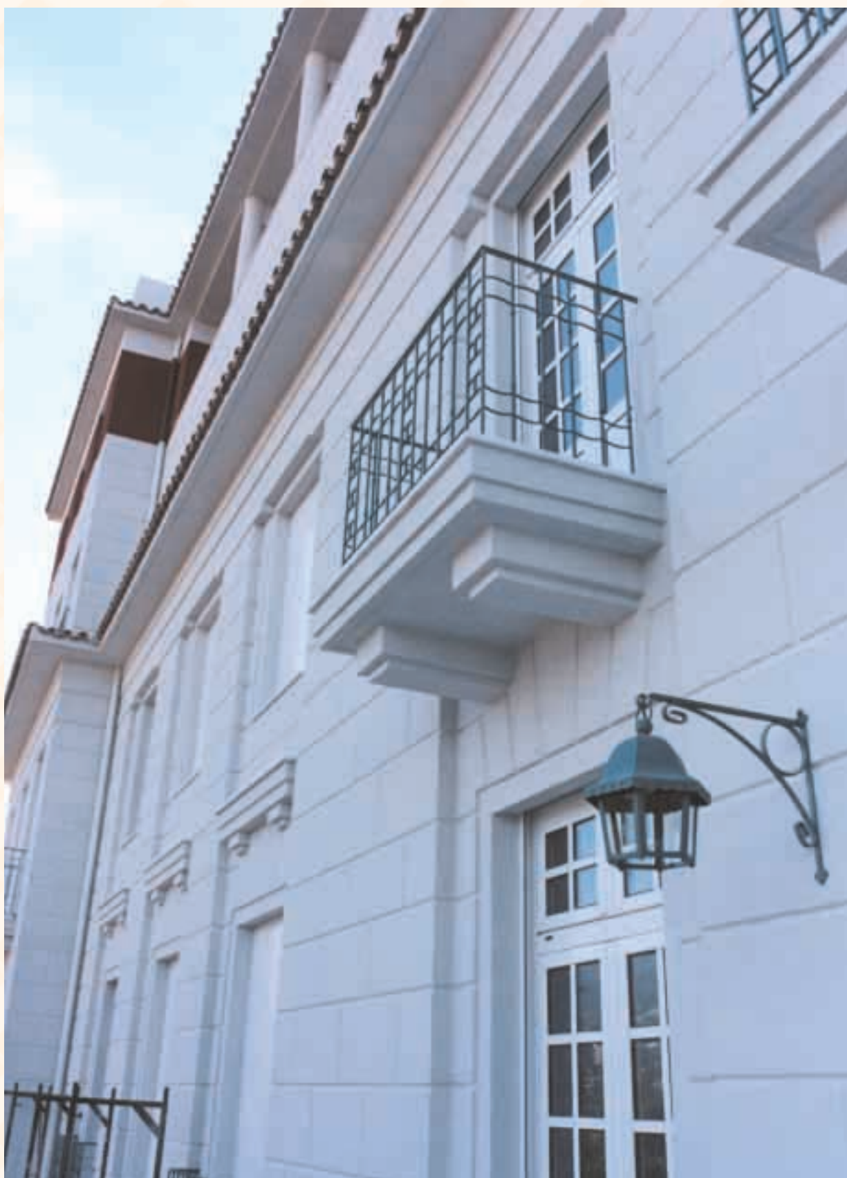
Νότια όψη ανακατασκευασθέντος κτιρίου γραφείων "ΟΛΥΜΠΙΑ", Κηφισιά
